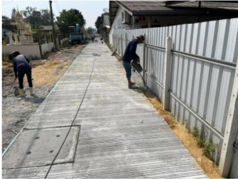
โครงการก่อสร้างถนน คสล. หมู่ที่ ๖ ตำบลวังเย็น
